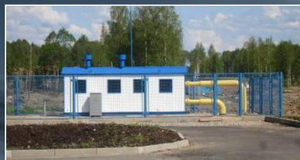
Газораспределительный пункт и газопровод
