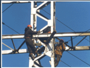
Реконструкция опорно-транспортной телефонной станции
