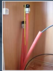
Опτικο-волоконная линия передач
