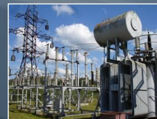
Линия ВЛ-10 кВ от ПС 110/10 кВ «Нифантово»
